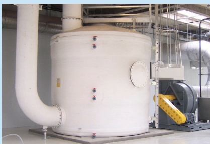
DEPURADOR DE TANQUE Obras de cabecera grandes, plantas de tratamiento integral y digestores 13,500 a 34,000 metros cúbicos por hora
